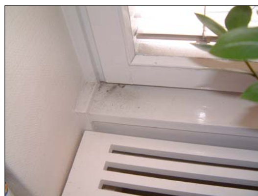
Invändigt har damm från den utvändiga saneringen trängt in vid karm
