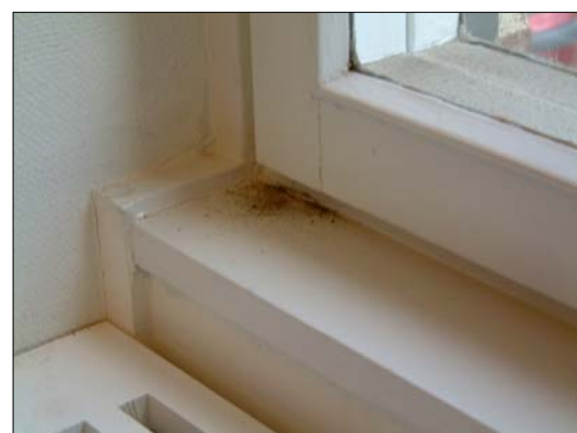
Invändigt har damm från den utvändiga saneringen trängt in vid karm
