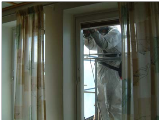
Sanering med feinkniv och slip
